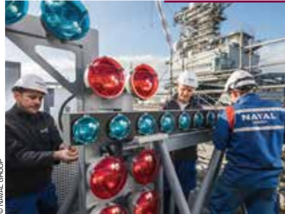
Modernisation des dispositifs d'aide à l'appontage. The modernization of landing systems.
